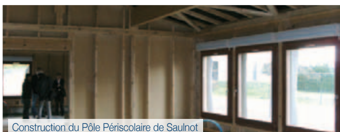
Construction du Pôle Périscolaire de Saulnot
