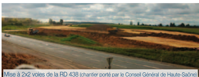
Mise à 2x2 voies de la RD 438 (chantier porté par le Conseil Général de Haute-Saône)
