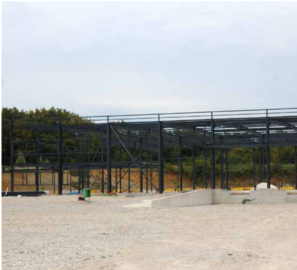
Chantier entreprise IENN septembre 2014
