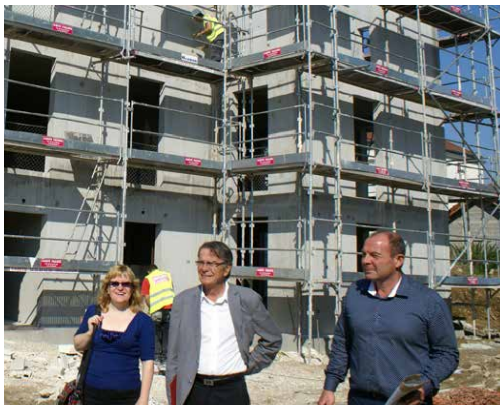
Résidence Senior : Catherine Fortes, Fernand Burkhalter et Damien Clemencier d'Habitat 70 en visite de chantier
