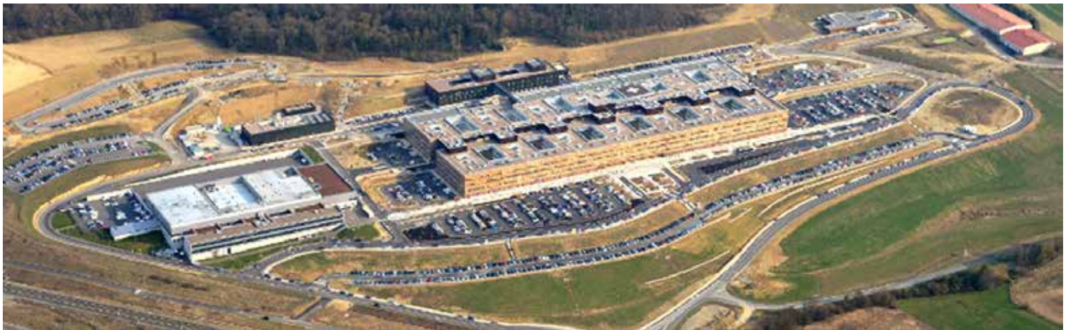
Hôpital Nord Franche-Comté vu du Ciel
