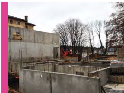
Démarrage des travaux
