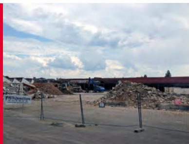
Chantier du Pâquis
