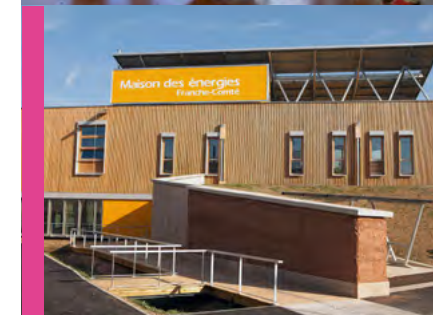
La Maison des énergies
