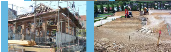
Brevilliers : réfection de la Fontaine
