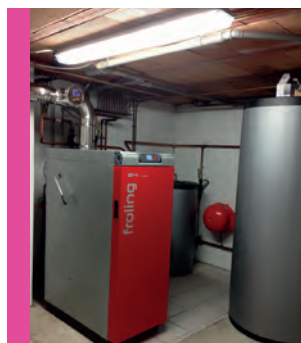
Travaux programme «habiter mieux» avant/après
