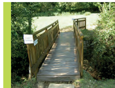
La passerelle du chemin des Princes avant et après rénovation
