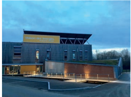
La maison des énergies
