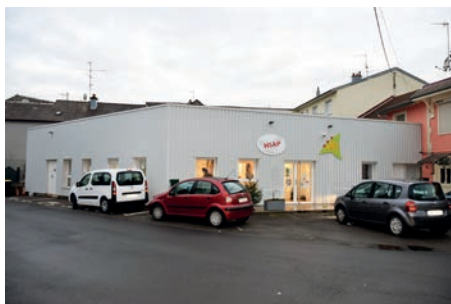
HMS – Nouveaux locaux 5 rue Anatole France à Héricourt
