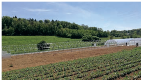
Jardins du Mont Vaudois – Site de Trémoins – Les tunnels en cours de montage et les premières cultures de pleins champs
