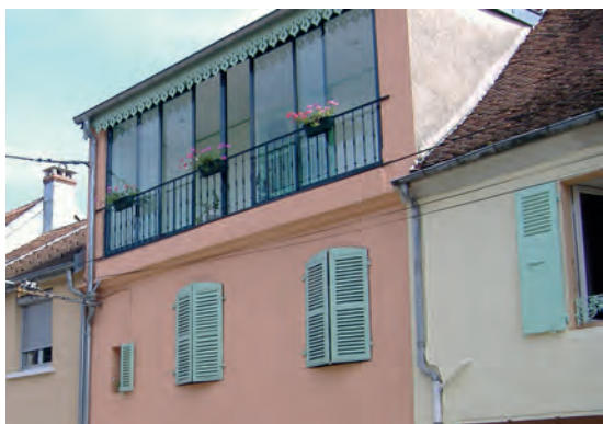
Exemple de rénovation
