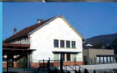
Extension du groupe scolaire de Luzé
