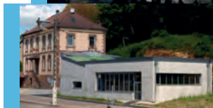
Construction de la salle de convivialité à Trémoins
