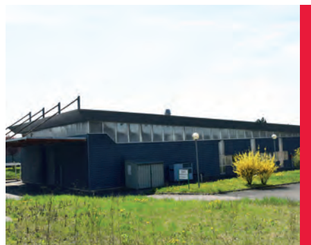
Locaux de l'ex ADAPEI
