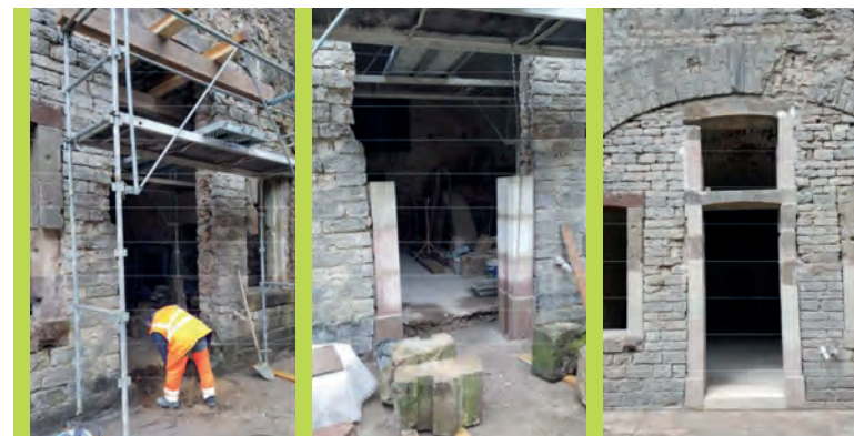
Rénovation du fort
