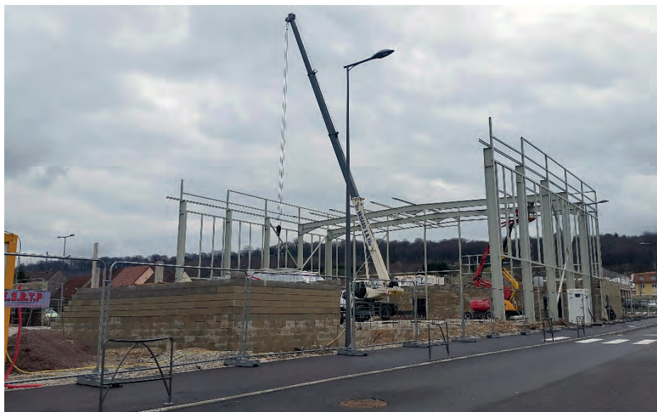
Le gymnase en construction
