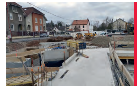
Le chantier du futur bassin
