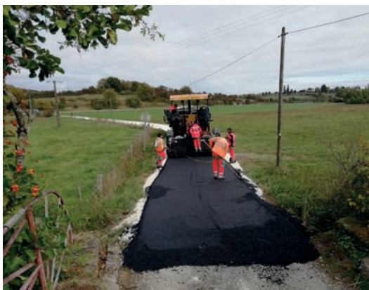
Travaux de la Voie du Tram
