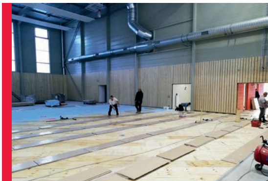
Aménagement du sol du gymnase
