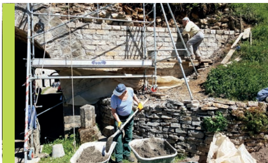
Rénovation du fort
