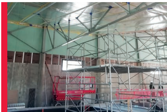
Travaux du bassin d'apprentissage
