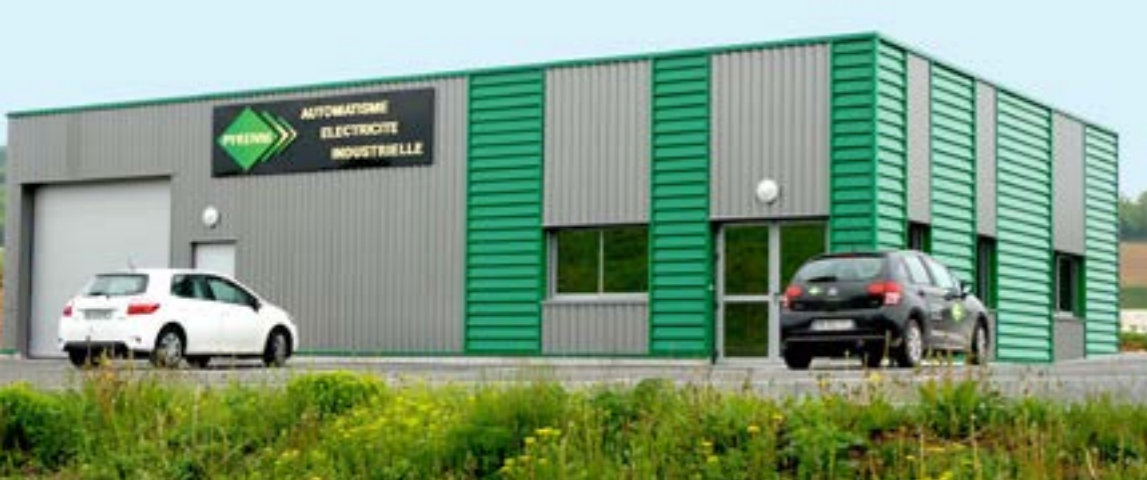
chantier d'implantation transports BERTRAND et entreprise PYRENNI
