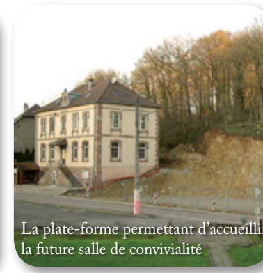
Démolition du préau de l'ancienne cour de récréation
