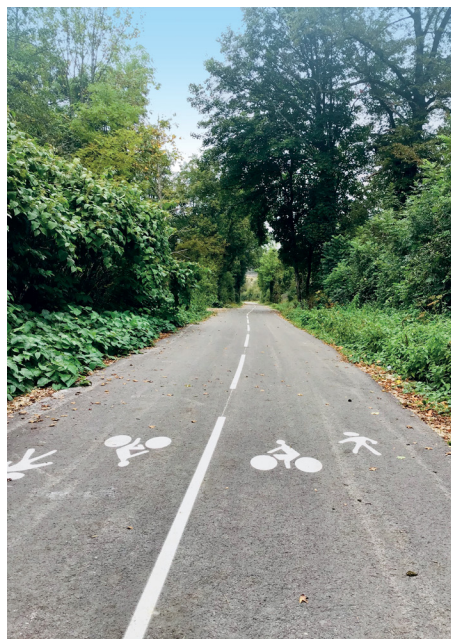
La voie du Tram
