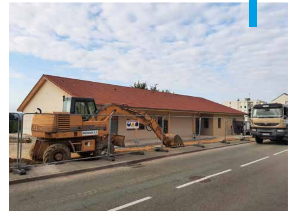
Pôle des Chenevières en travaux
