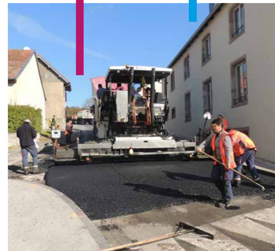
Travaux à Laire
